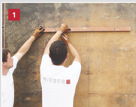
1 Markieren des oberen Rahmen-Lichtmaßes auf der Außenschalung. (Wasserwaage verwenden!)
