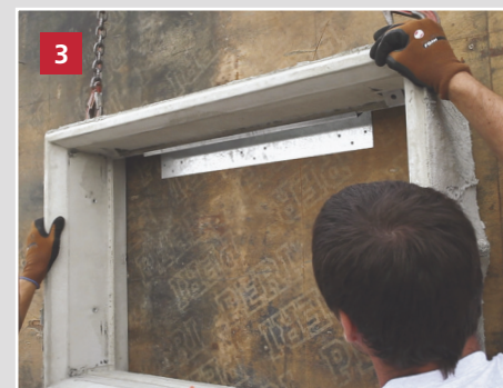
3 Aufhängen der Wechselzarge an die Montage-Leiste. Zuvor das mitgelieferte Holzkreuz entnehmen!
