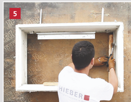
5 Fixieren der Zarge an die Außenschalung durch Annageln der drei mitgelieferten Leisten (links, rechts und unten)
