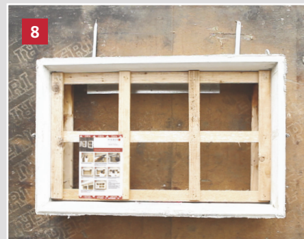
8 Montage der Wechselzarge ist abgeschlossen. Nun Anbringen der Innenschalung. Fertig!
