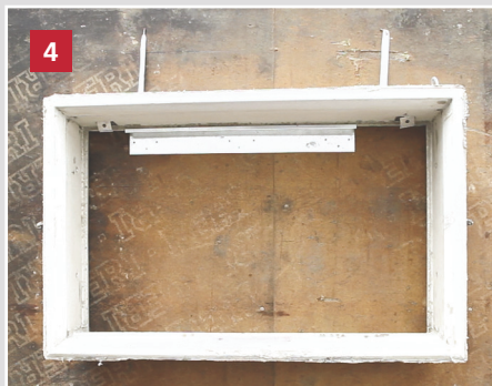
4 Sichern der Zarge gegen Abrutschen durch das Annageln der zwei Sicherungsbänder an die Außenschalung.
