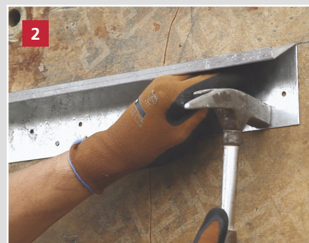
2 Annageln der Montage-Holzleiste (im Lieferumfang enthalten) bzw. der mehrfach verwendbaren Montage-Schiene (muss separat bestellt werden) an die Außenschalung. Nägel schräg einschlagen oder Spax verwenden.
