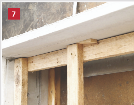
7 Anpassen eventueller Toleranzen des Holzkreuzes mit den vier mitgelieferten Holzkeilen (Tüte). Nicht zu fest einschlagen! Zarge dabei nicht nach außen drücken!
